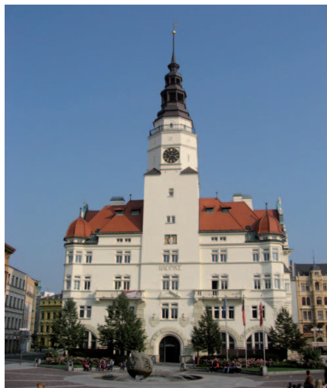
W budynku zabytkowej wieży miejskiej, górującej nad Opawą, mieści się siedziba Urzędu Miasta oraz czeskiej części Euroregionu Silesia
